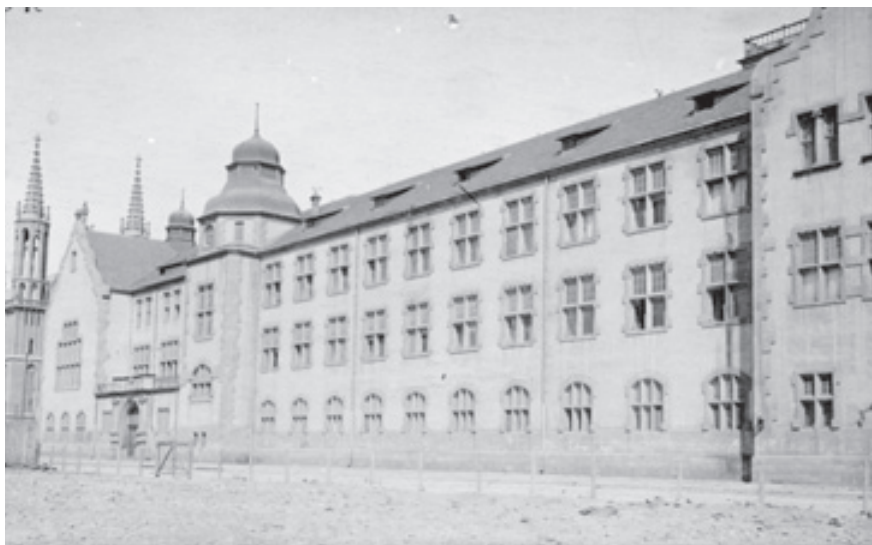
Университетское здание в Баку. 1924 г.
